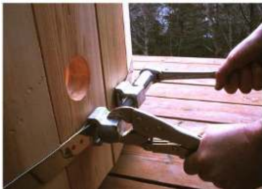
Figuur 8.2 Draai de sluiting van de duigen aan.
