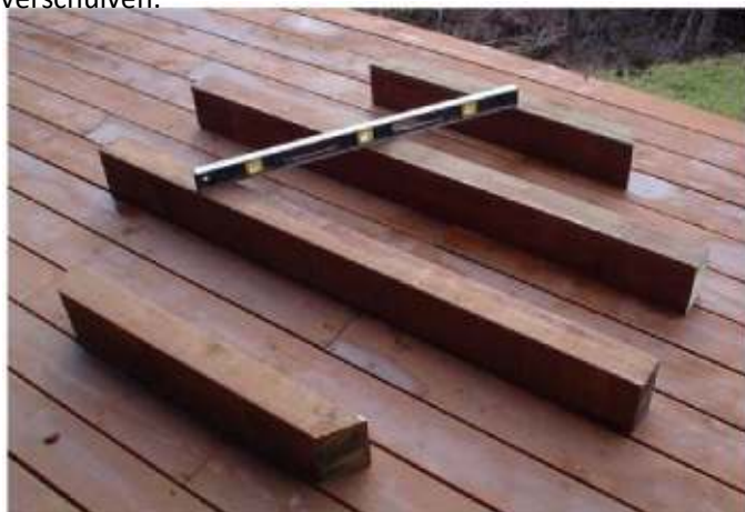
Figuur 4.2, leg ze evenwijdig en waterpas!
