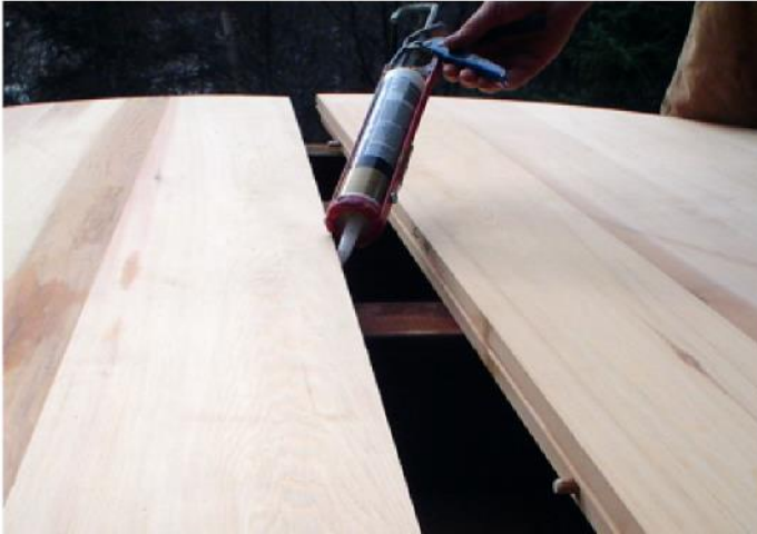
Figuur 5.2 Aanbrengen van siliconenkit zorg dat de onderkant droog- en stof vrij is.
