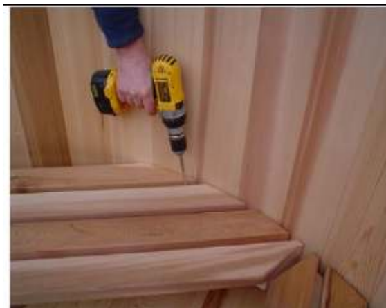
Figuur 9.2 Schroef de bankdelen vast
