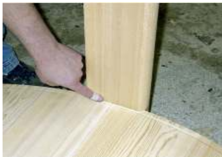
Figuur 6.1 Aanbrengen van eerste slat.
