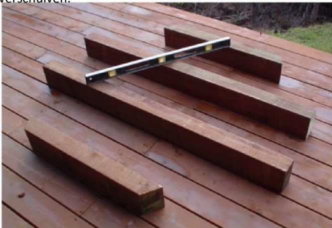
Figuur 4.2, leg ze evenwijdig en waterpas!
