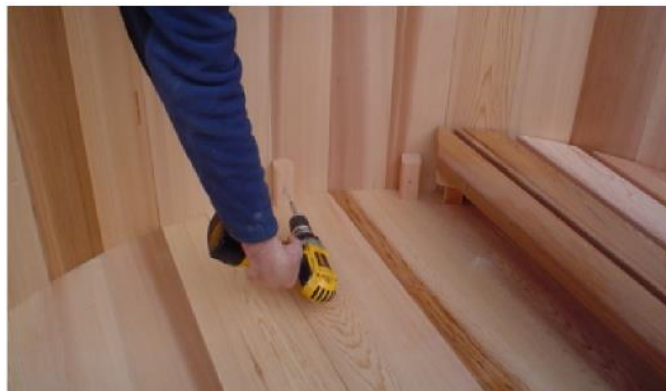
Figuur 9.1 Schroef de bank blokken vast, alleen in het midden van de slat schroeven
